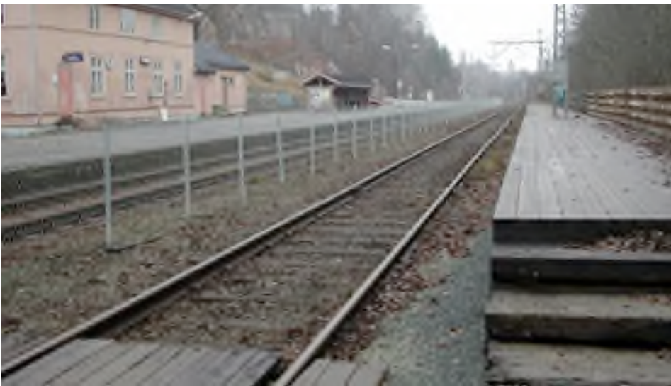
Figur 26: Plattform 2 på Heggedal stasjon. [10]
